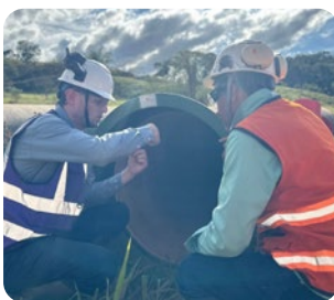
Acompanhamento de obras
