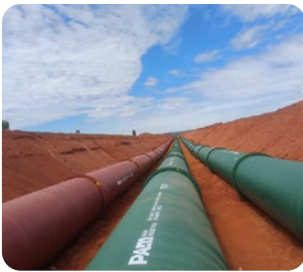
Teste de estanqueidade
