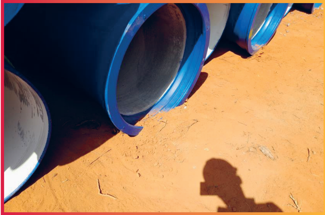
↳ Tubos em contato com o piso
