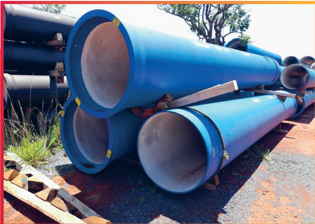
↳ Espaçador de madeira quebrado (risco de queda de material)
