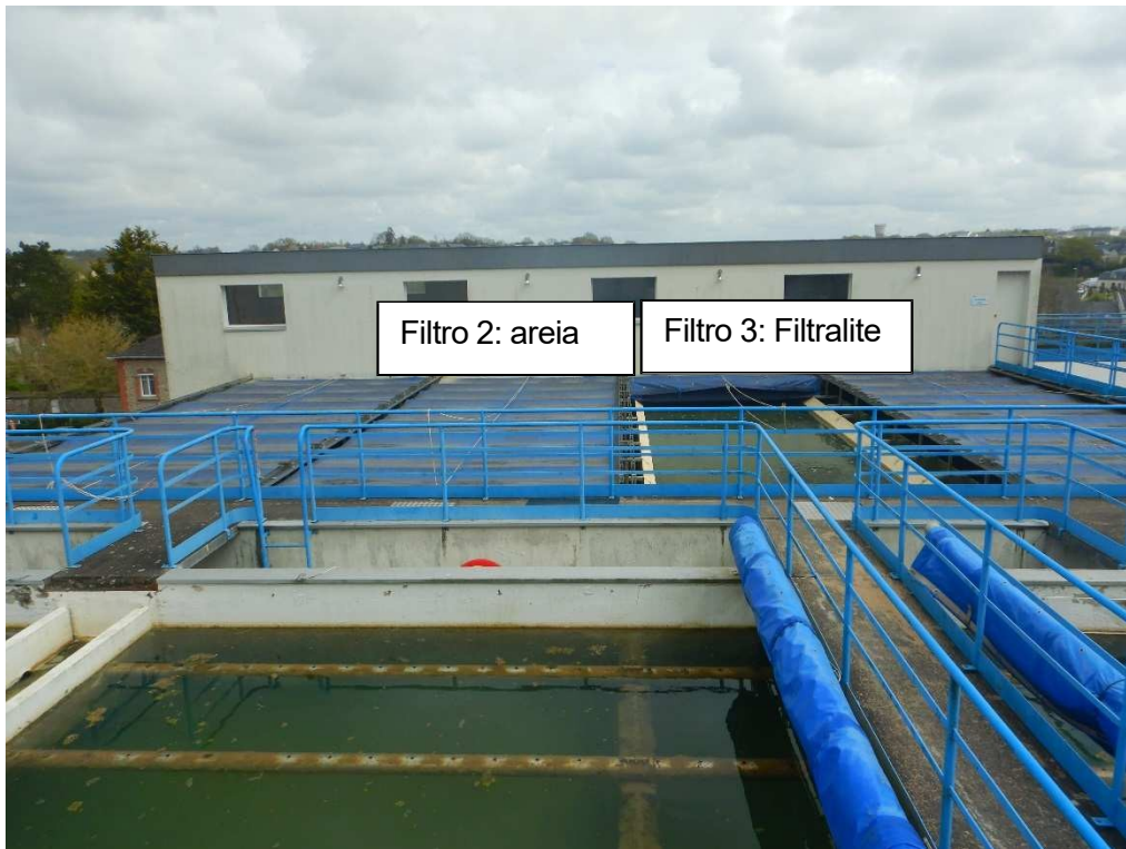
Filtro 3 preenchido com filtralite
