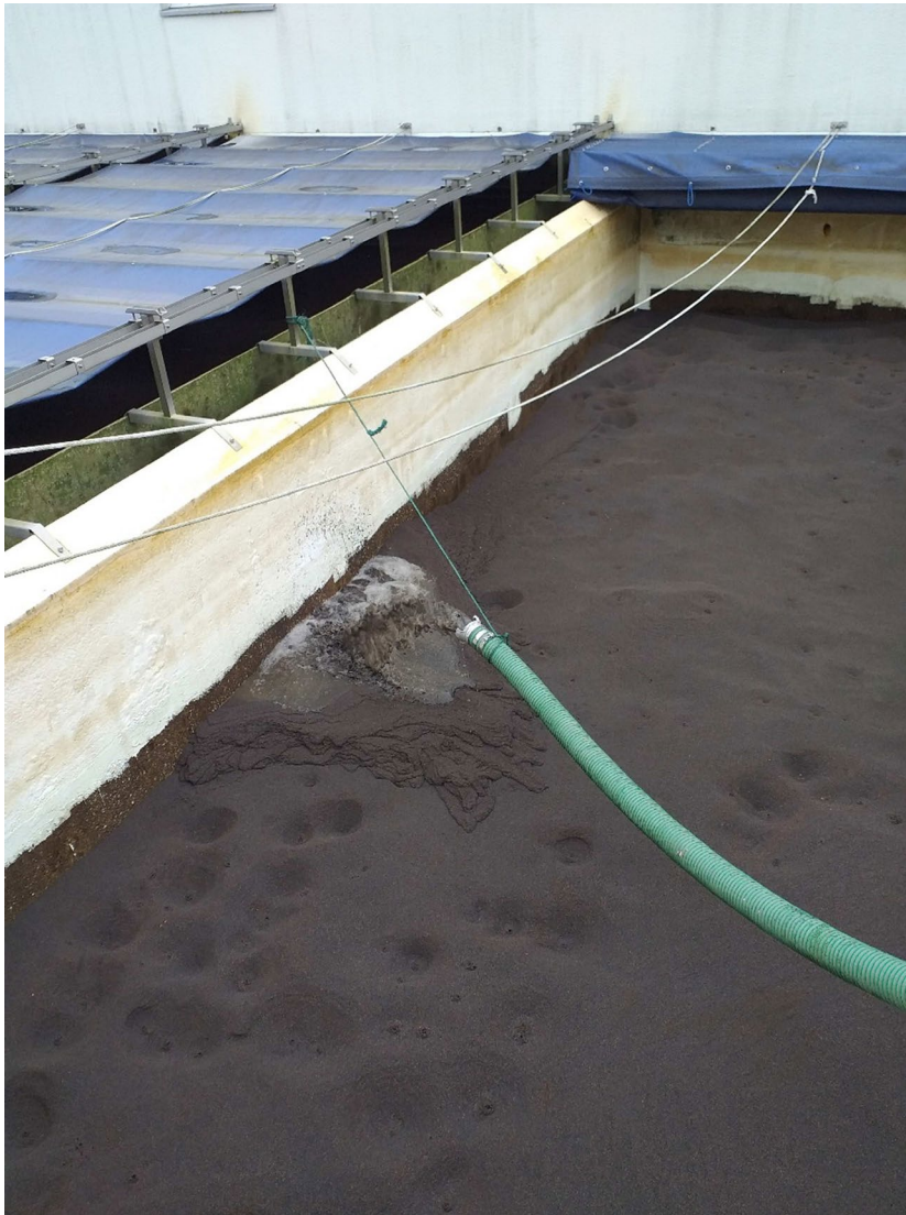
Carregamento de Filtralite
