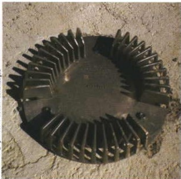
Figura 7 – Captador instalado em laje (visão superior)
