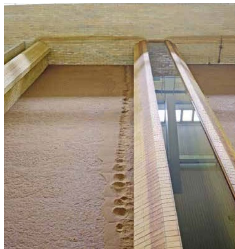
SUSPENSOS: os dois últimos leitos filtrantes de areia a serem substituídos em breve
